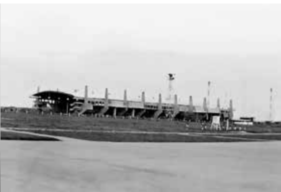
Ginásio de Esportes, ainda em construção.
