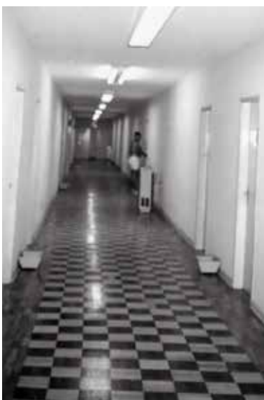
Corredor dos apartamentos.
