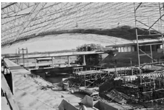
Interior do ginásio, ainda em construção.
