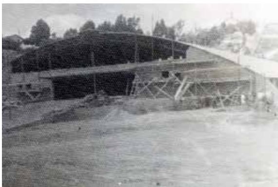
Cinema em construção.
